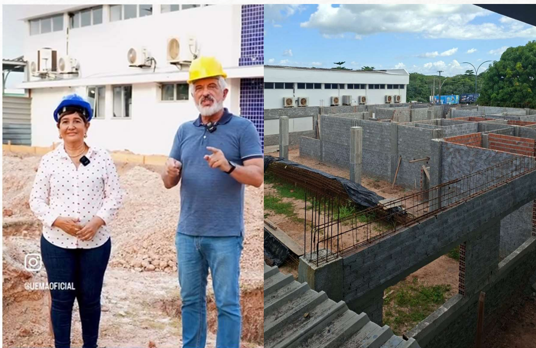
Reitor visita e avalia o início das obras do RU Campus Bacabal.
