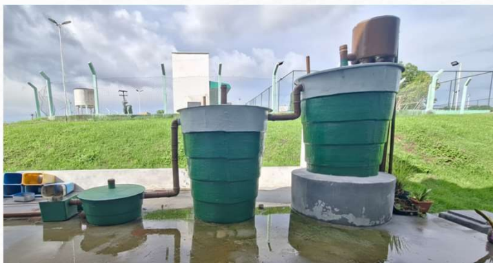
Conclusão da ETE do campus.
