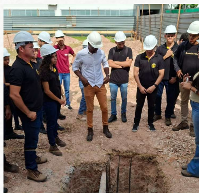
Visita técnica dos alunos do Curso de Engenharia Civil a obra de construção do RU.
