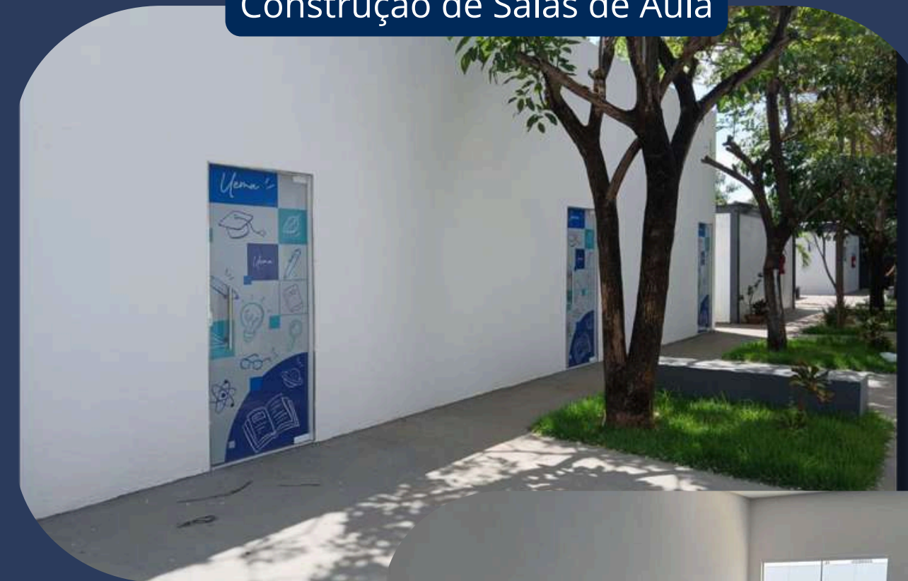
Construção de Salas de Aula
