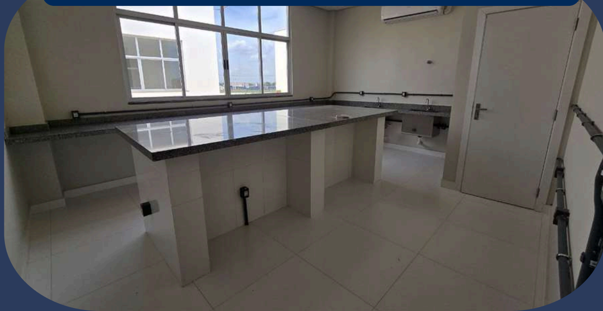
Construção de 3 "cubos" de Laboratórios
