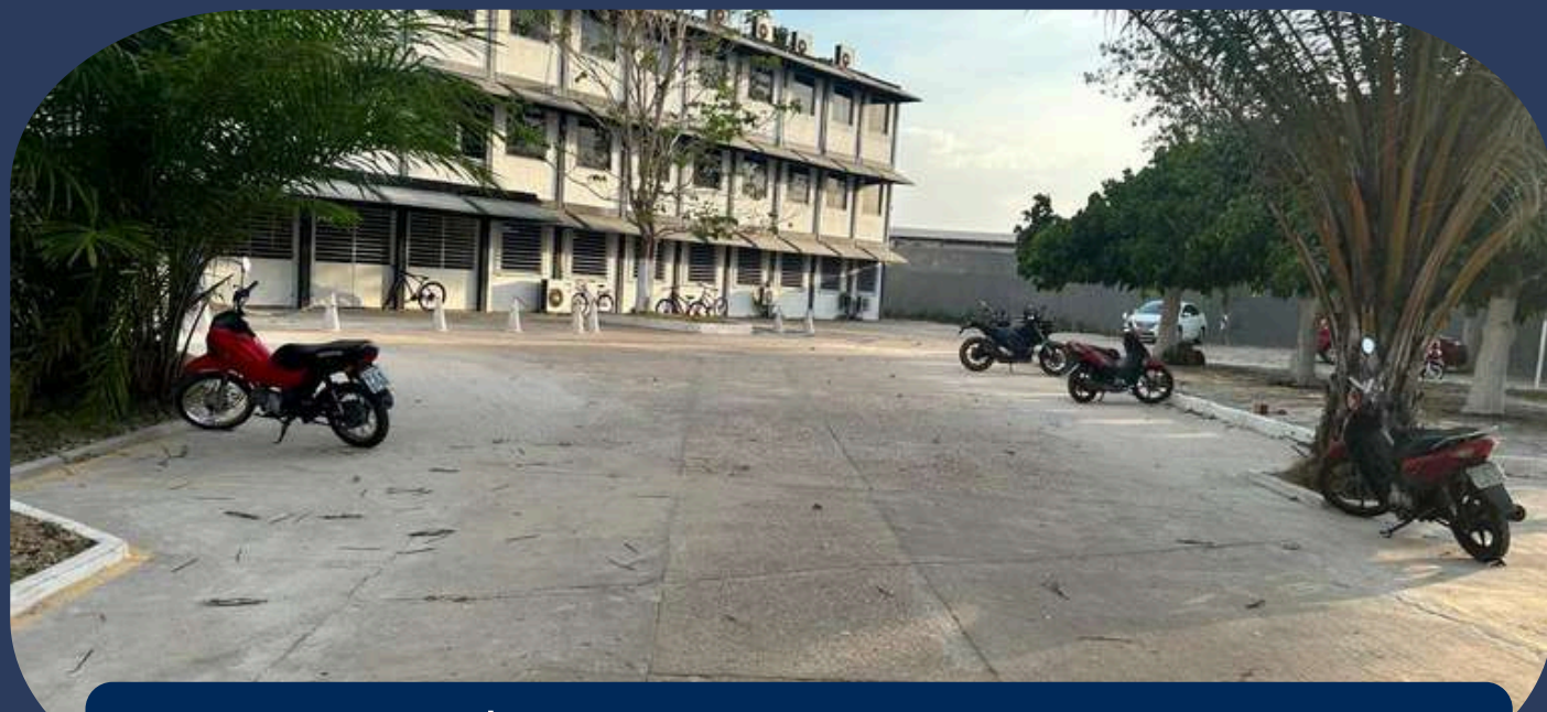
Construção de Muro Externo e Estacionamento
