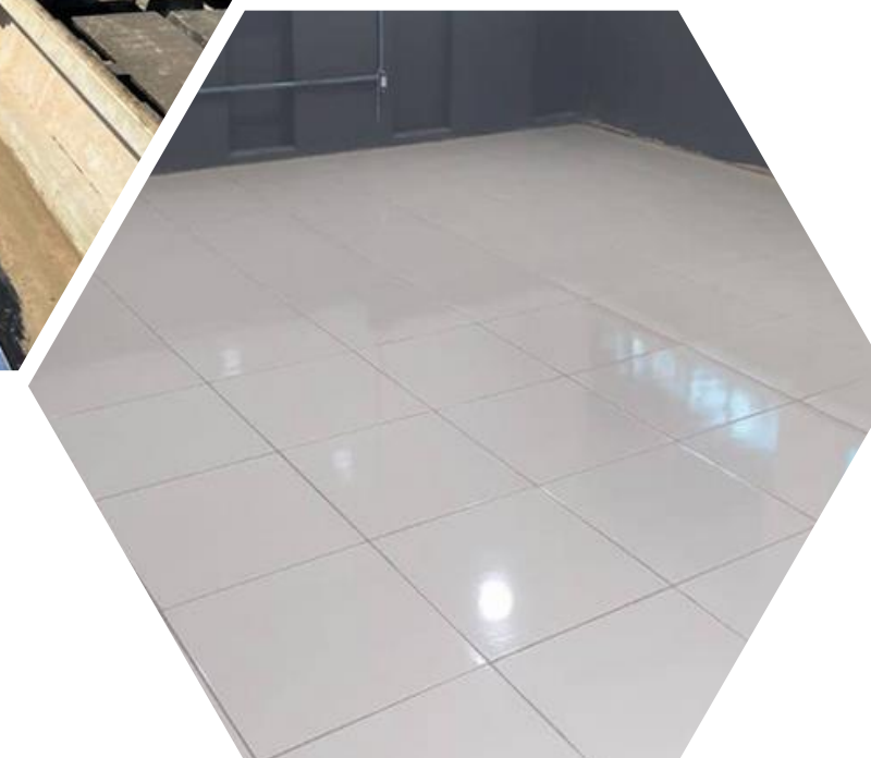
Substituição de piso em Grajaú
