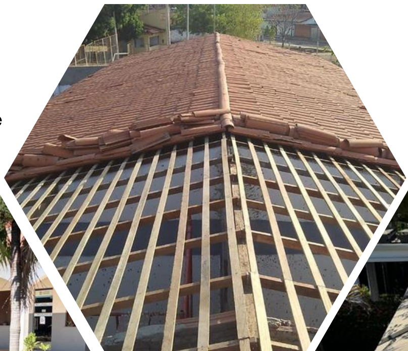
Início da substituição da cobertura de Timon
