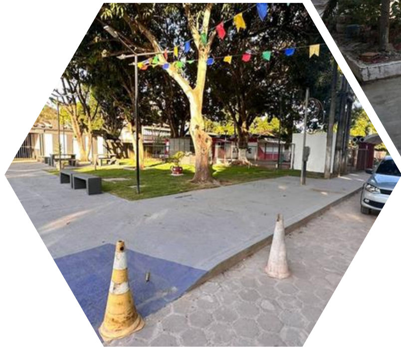
Construção de estacionamento em Pedreiras
