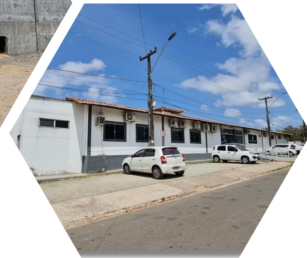
Novas Instalações Elétricas no Hospital Veterinário
