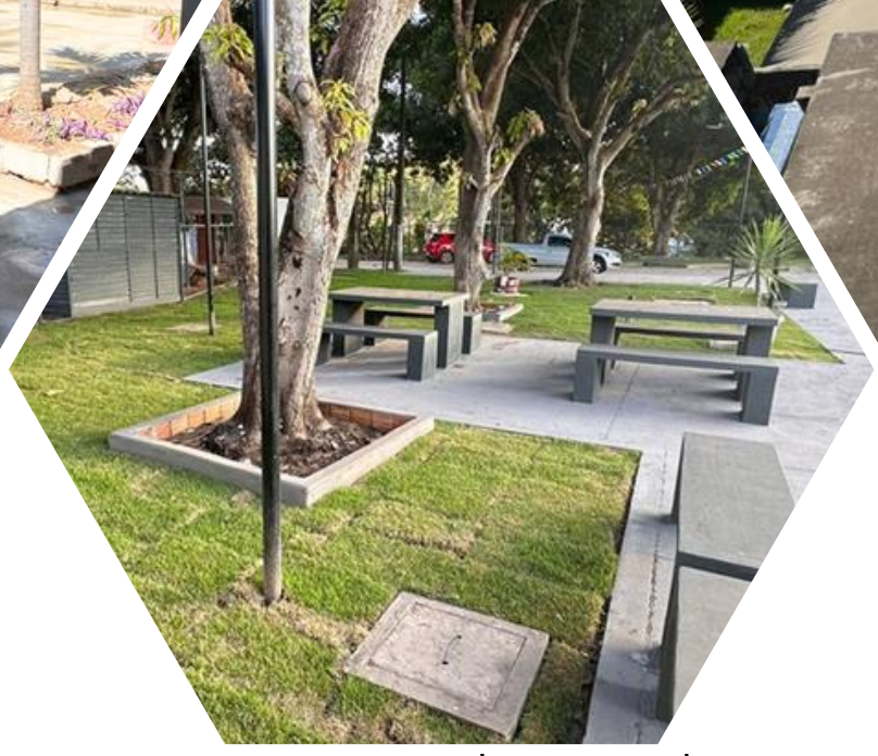
Construção de área de vivência em Pedreiras
