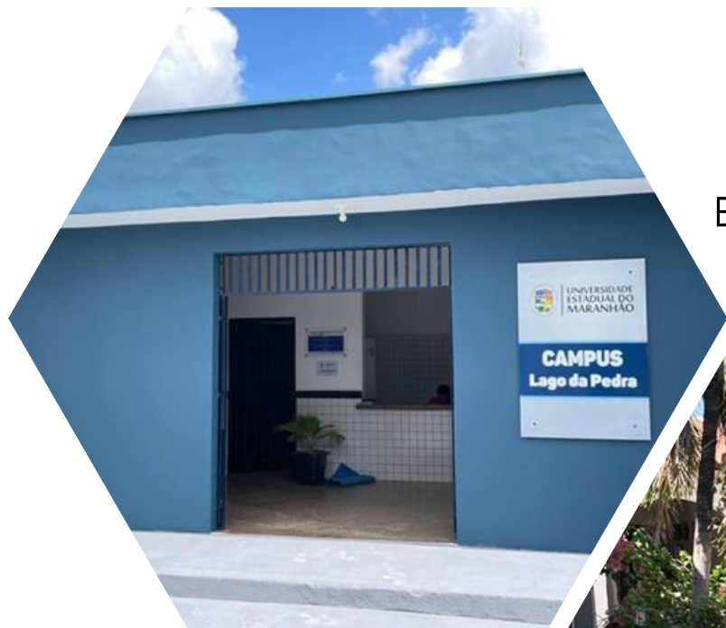
Adequação da Fachada de Lago da Pedra
