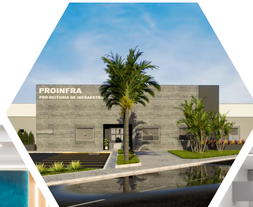
Reforma da PROINFRA
