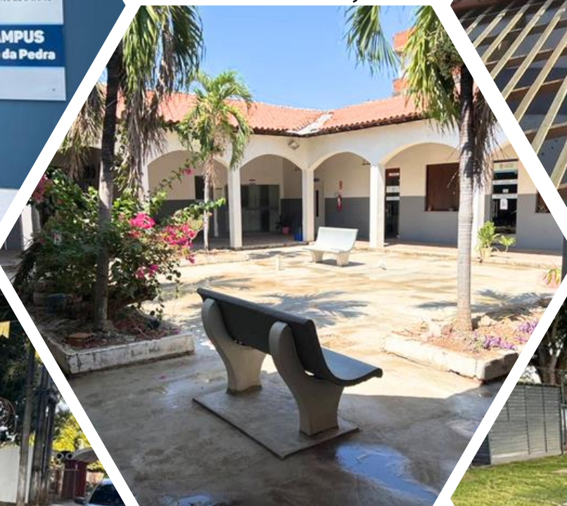
Reforma do patio de Balsas e execução de ETE (Fossa, filtro e sumidouro)
