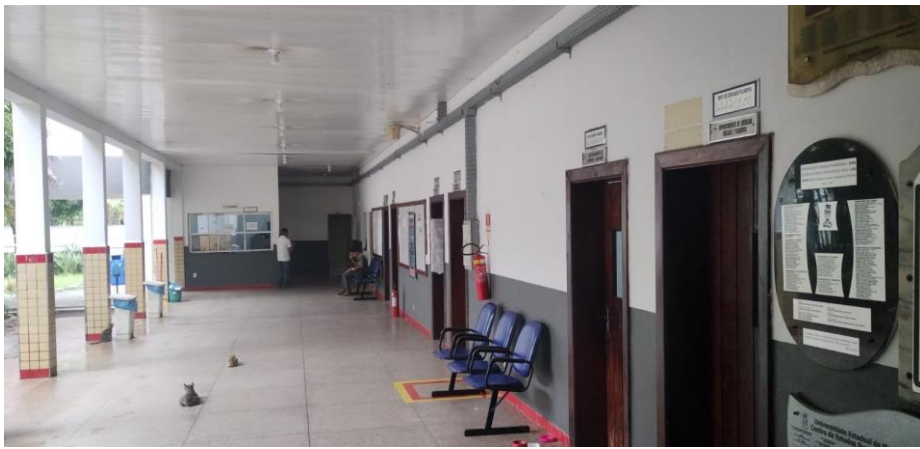
Vista do Pavilhão A – Direção do Campus, Departamentos e Protocolo
